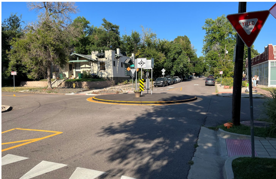
Mini roundabout on a Bicycle Boulevard
