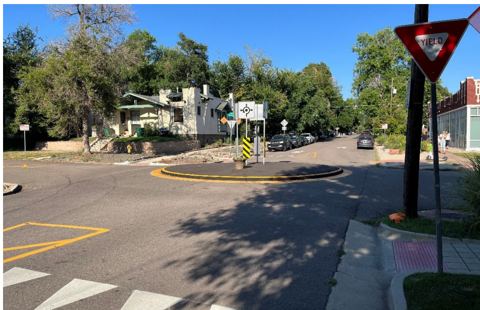
Mini roundabout on a Bicycle Boulevard
