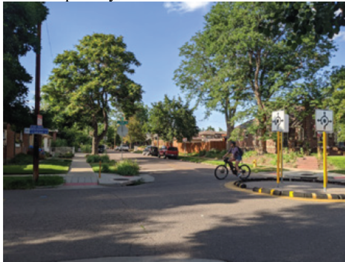
Mini roundabout on a Bicycle Boulevard
